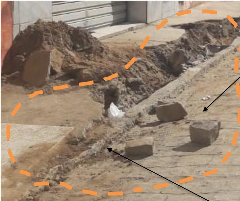
Área no entorno do Meio-fio que será demolida e reconstruída.
