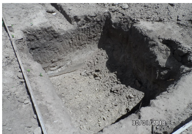
Foto-04 (Escavação das sapatas)
