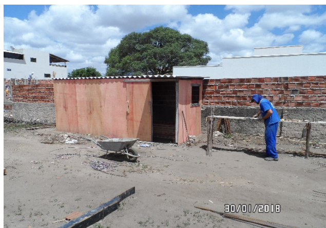
Foto-02 (Barracão da obra)
