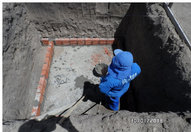
Foto-05 (Lastro de concreto)
