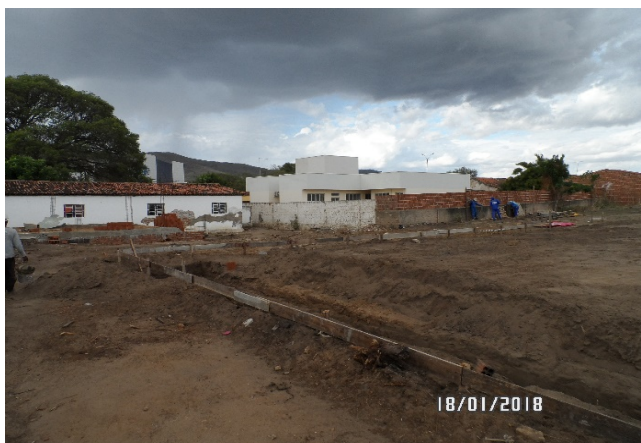
Foto-03 (Localização da obra)
