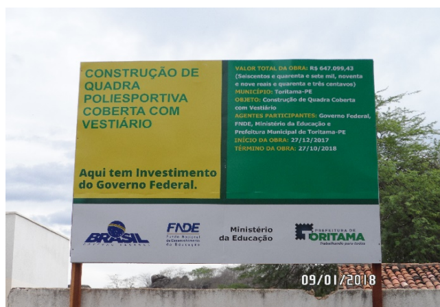
Foto-01 (Placa da Obra)
