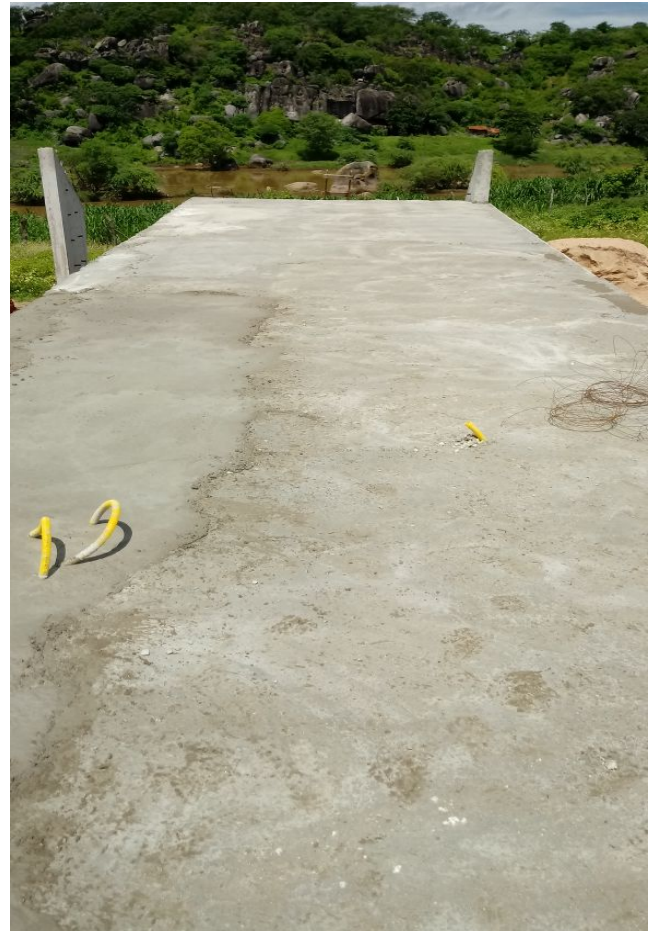
Foto-11 (Laje concretada VESTIÁRIO)
