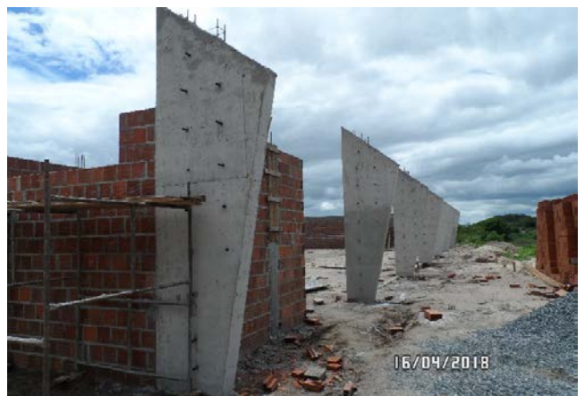
Foto-06 (Pilares Concretado)
