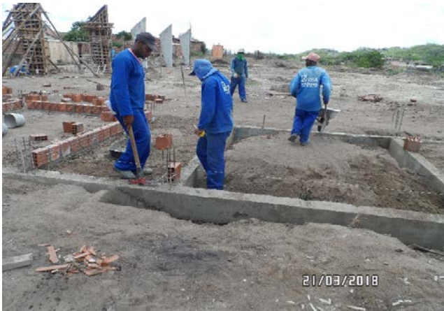
Foto-01 (Aterro do caixão - VESTIÁRIO)
