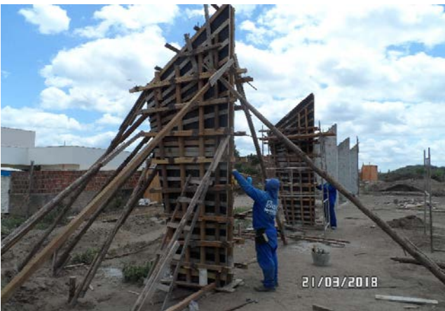
Foto-03 (Forma - Pilares)
