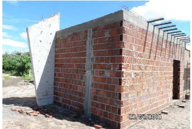
Foto-08 (Vigas Superior)
