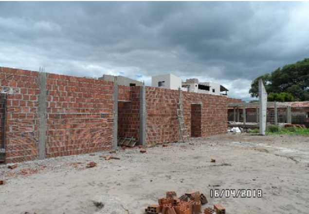
Foto-09 (Alvenaria c/ e=9cm)
