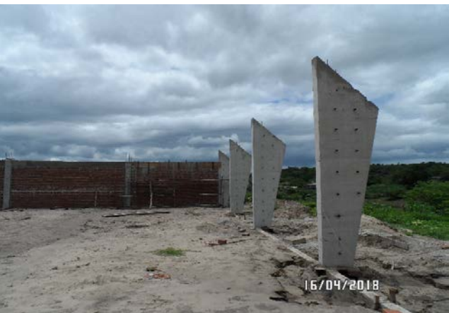
Foto-05 (Pilares Concretado)
