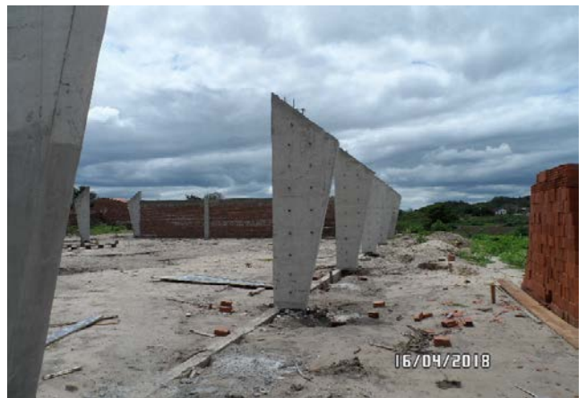
Foto-04 (Pilares: P23 a P30)
