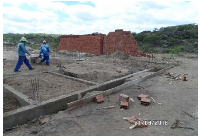
Foto-02 (Aterro do caixão - VESTIÁRIO)
