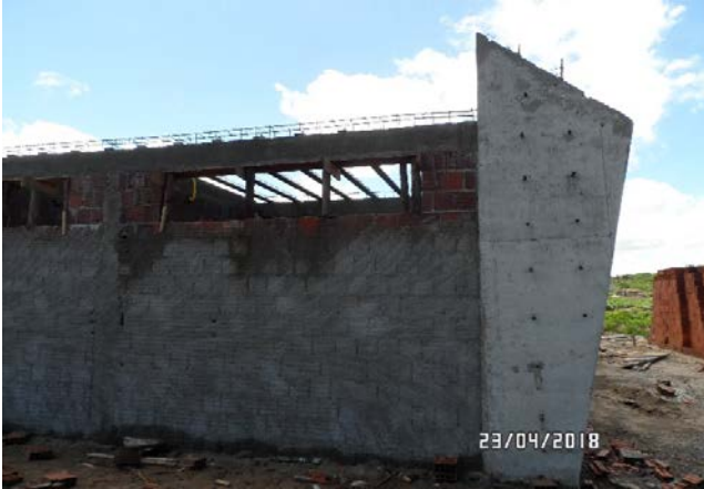
Foto-07 (Vigas Superior)
