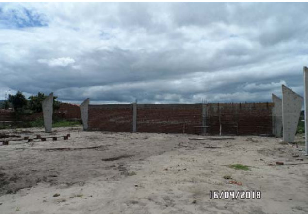
Foto-10 (Alvenaria c/ e=14cm)
