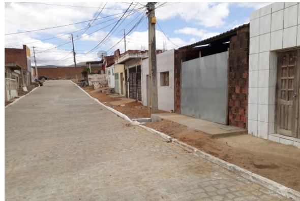
Foto-02 (RUA PROJETADA 01-Valetim-III)
