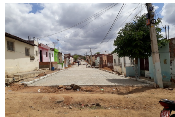
Foto-06 (RUA PROJETADA 02 - Valetim-III)
