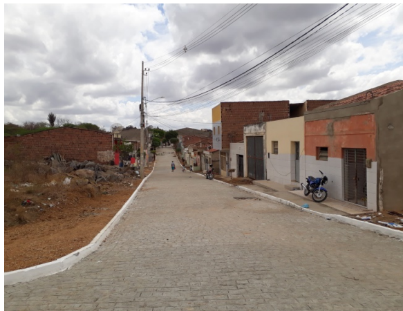
Foto-01 (RUA PROJETADA 01-Valetim-III)
