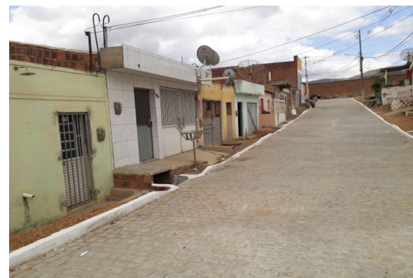
Foto-04 (RUA PROJETADA 01-Valetim-III)
