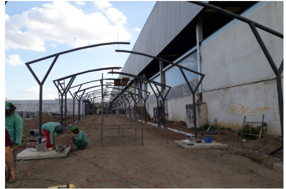
ITEM 3.3.1 (Estrutura Metálica - ARCOS)
