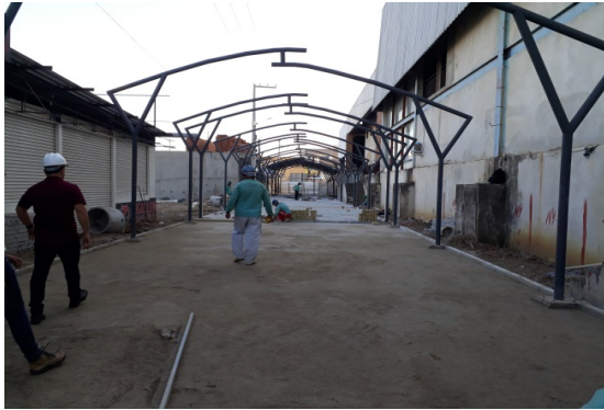
ITEM 3.2.1 (Estrutura Metálica - PÓRTICOS)
