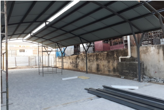
ITEM 3.3.2 (Telhamento com telhas de aço)
