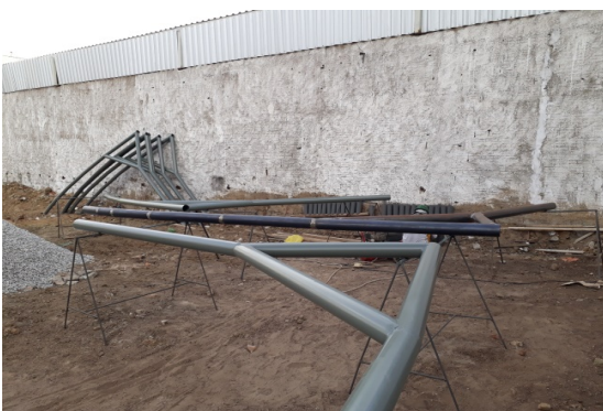
ITEM 3.3.1 (Estrutura Metálica - ARCO)
