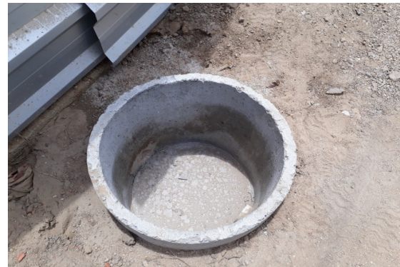
ITEM 2.4.4 (Caixa de Inspeção)
