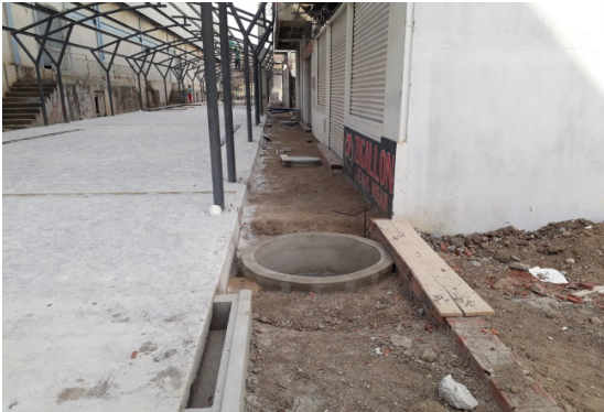
ITEM 2.4.3 (Poço de Visita)
