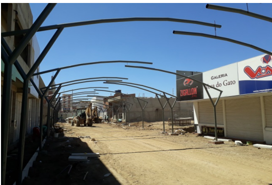
ITEM 3.2.1 (Estrutura Metálica - PÓRTICOS)
