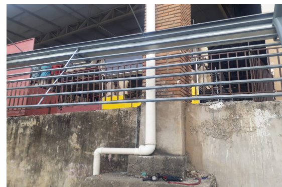
ITEM 3.2.2 (Estrutura Metálica - BRISSES)
