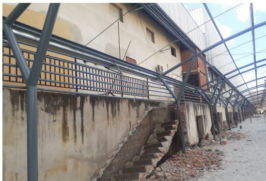
ITEM 3.2.2 (Estrutura Metálica - BRISSES)
