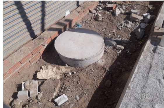
ITEM 2.4.4 (Caixa de Inspeção)
