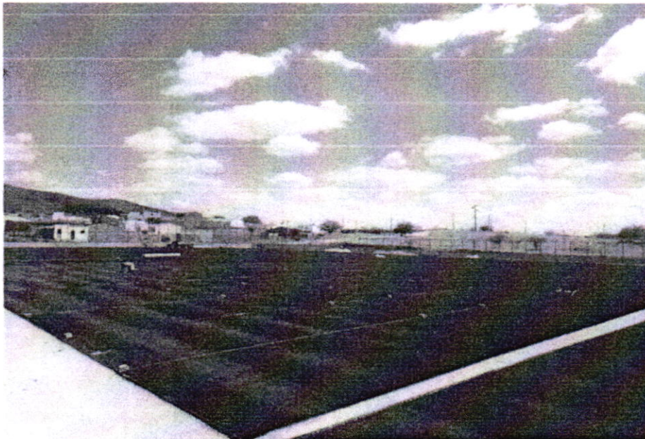
Foto-05 (PARTE DOS TAPETES JÁ ASSENTADOS E COLADOS)
