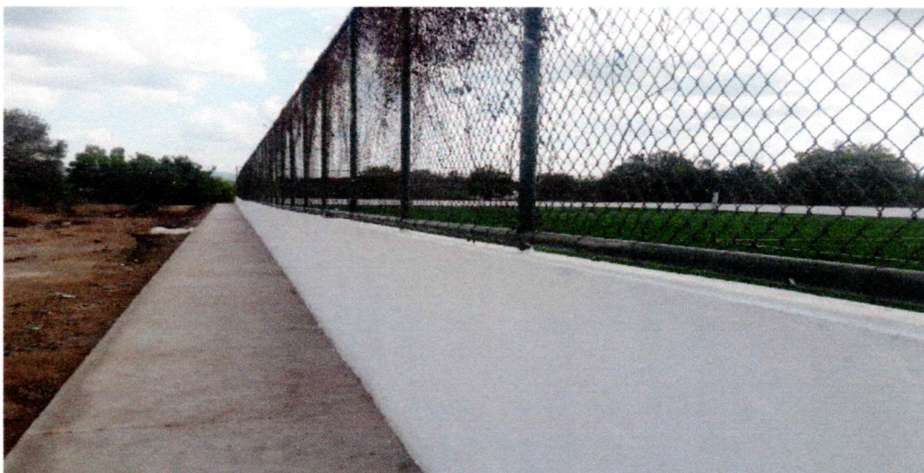
Foto-02 (Passeio executado)
