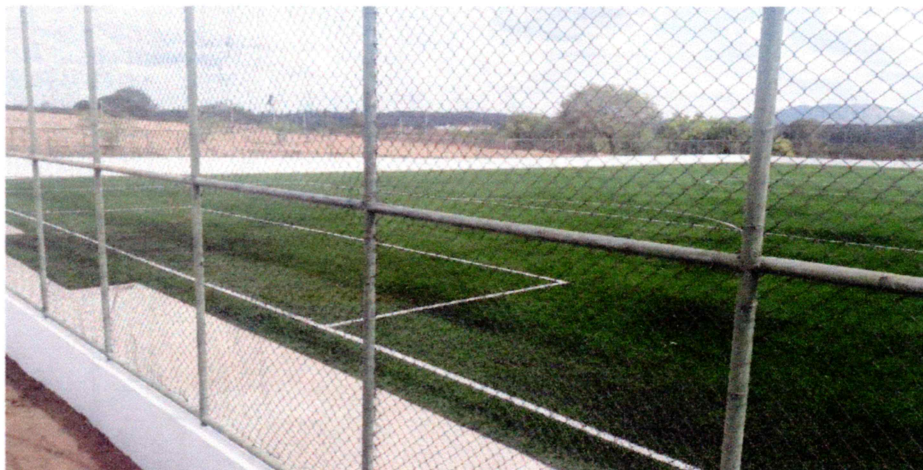
Foto-03 (Restante do gramado concluído)
