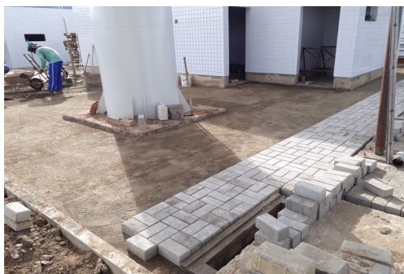
Trecho de Meio Fio em volta dos banheiros
