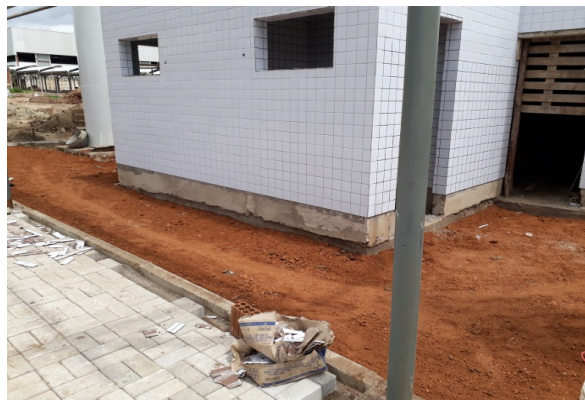
Trecho de aterro em volta dos banheiros
