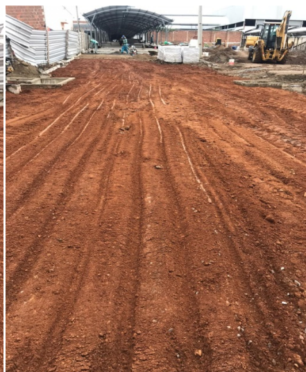
Trecho de aterro em volta dos banheiros
