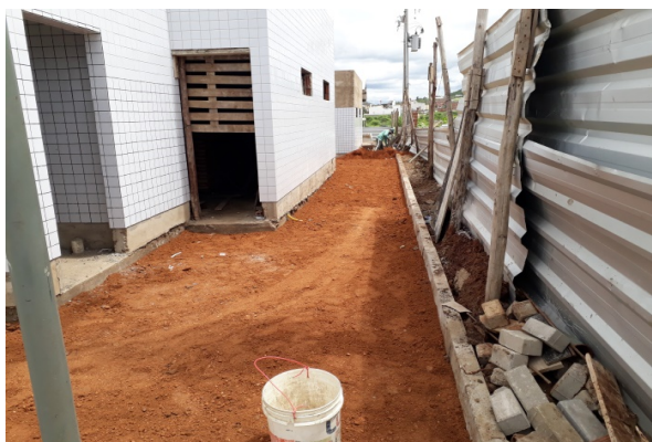
Trecho de aterro em volta dos banheiros
