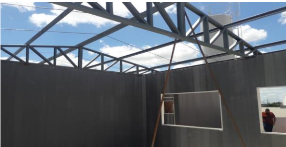
FOTO-10 (Estrutura metálica de cobertura...)
