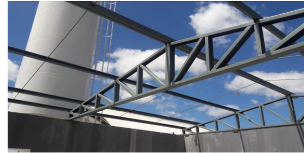
FOTO-11 (Estrutura metálica de cobertura...)
