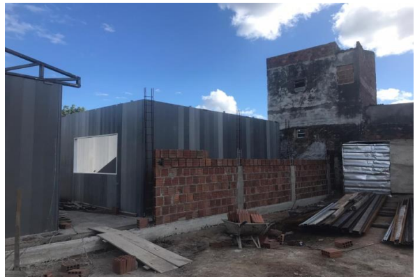
FOTO-4 (Montagem e Concretagem das paredes....)
