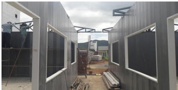
FOTO-5 (Montagem e Concretagem das paredes....)
