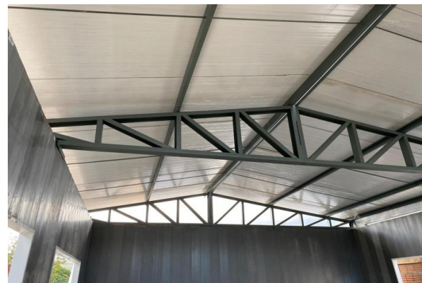
FOTO-13 (Coberta c/ telha termoacústica...)
