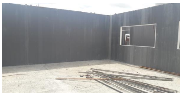
FOTO-6 (Montagem e Concretagem das paredes....)
