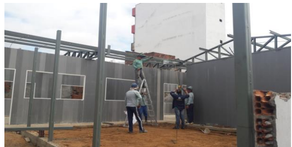
FOTO-9 (Colunas metálicas....)
