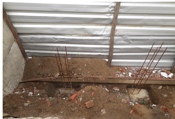
FOTO-2 (Escavação das Sapatas e Valas....)
