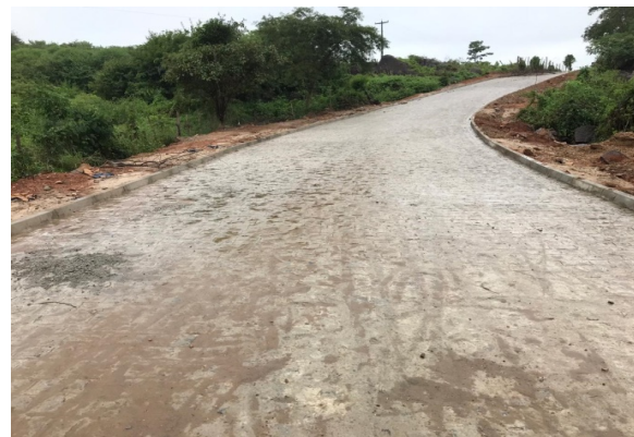
FOTO-6 (ITEM 2.3 - Pavimentação)
