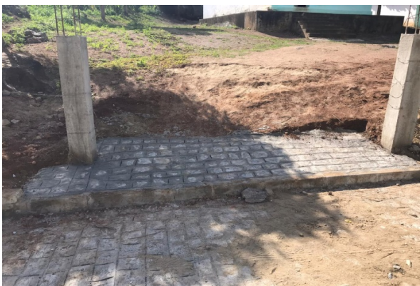
FOTO-5 (ITEM 2.3 - Pavimentação) (ENTRADAS DAS RESIDÊNCIAS AO LONGO DA VIA)
