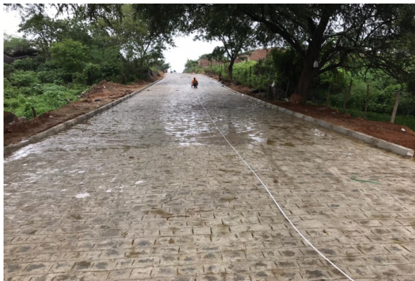
FOTO-7 (ITEM 2.3 - Pavimentação)
