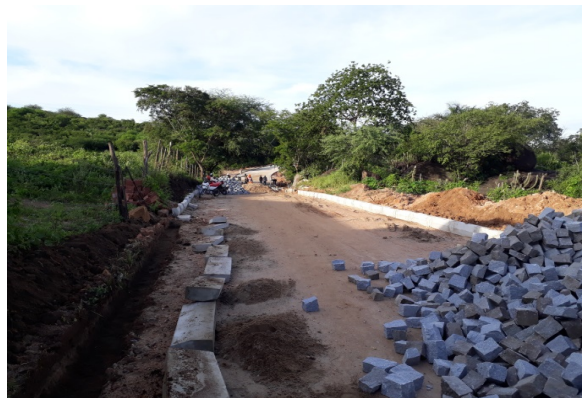
FOTO-4 (ITEM 2.2 - Meio Fio)
