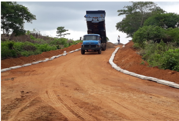
FOTO-3 (ITEM 2.2 - Meio Fio)
