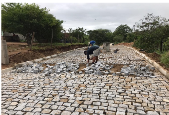
FOTO-9 (ITEM 2.3 - Pavimentação)
