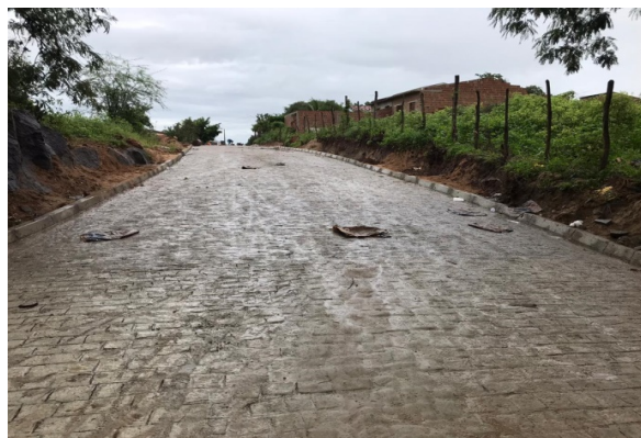
FOTO-8 (ITEM 2.3 - Pavimentação)
