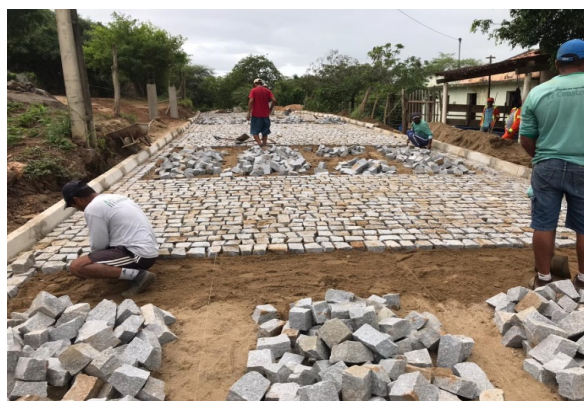
FOTO-10 (ITEM 2.3 - Pavimentação)
