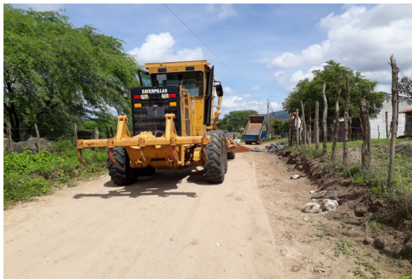
FOTO-1 (ITEM 2.1 - Regularização)
