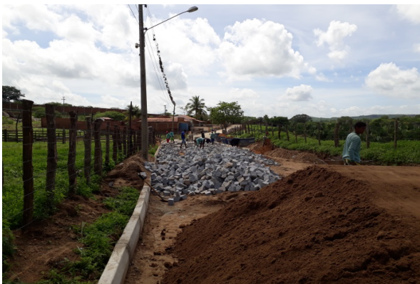
FOTO-3 (ITEM 2.2 - Meio Fio)
