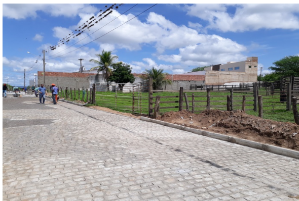
FOTO-9 (ITEM 2.3 - Pavimentação)
