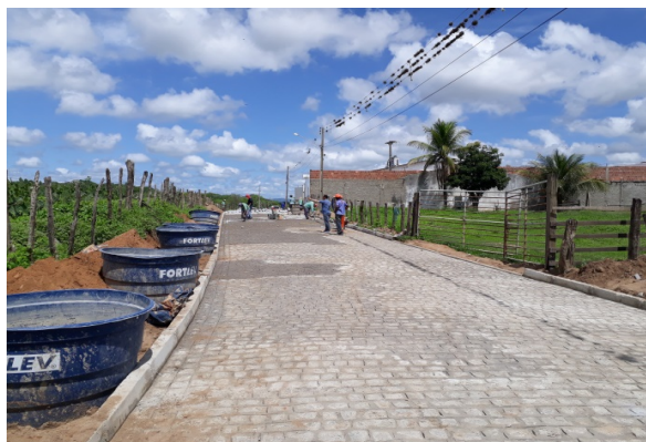
FOTO-8 (ITEM 2.3 - Pavimentação)
