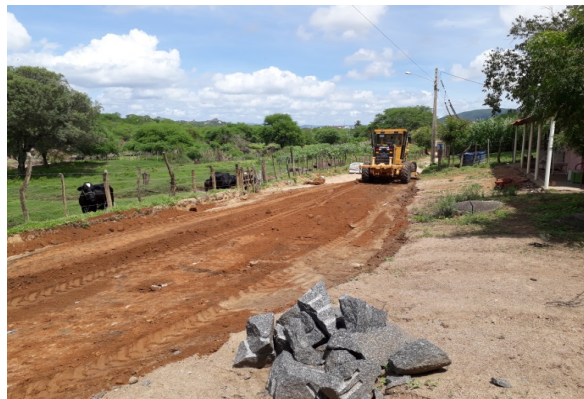
FOTO-2 (ITEM 2.1 - Regularização)
