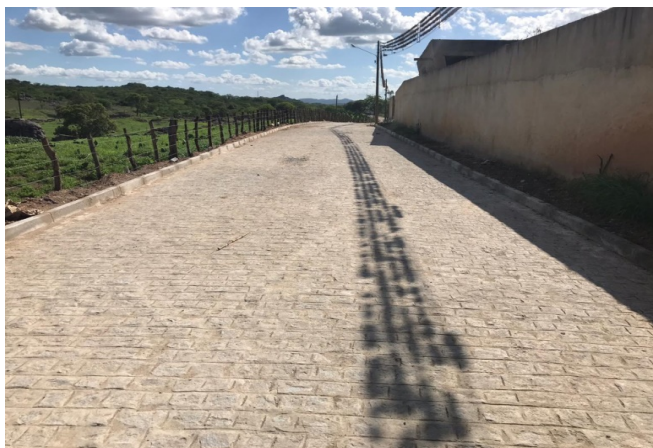
FOTO-6 (ITEM 2.3 - Pavimentação)
