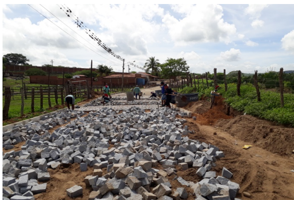
FOTO-4 (ITEM 2.2 - Meio Fio)
