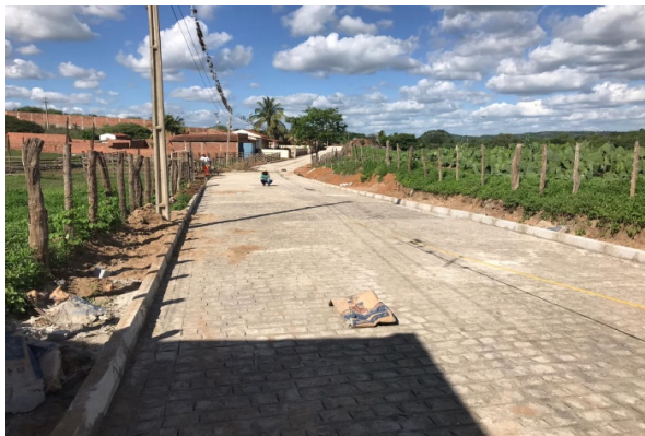
FOTO-7 (ITEM 2.3 - Pavimentação)
