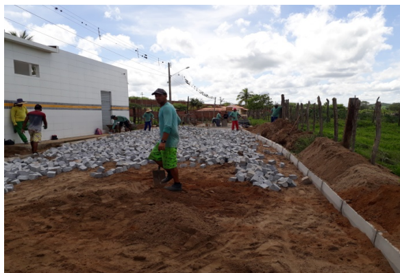
FOTO-10 (ITEM 2.3 - Pavimentação)
