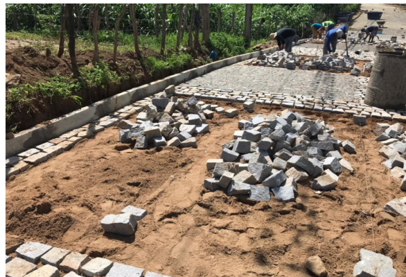
FOTO-2 (ITEM 2.2 - Meio Fio)
