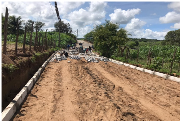
FOTO-1 (ITEM 2.2 - Meio Fio)
