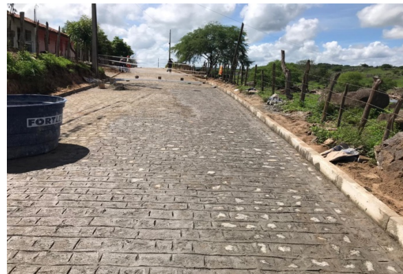
FOTO-4 (ITEM 2.3 - Pavimentação)
