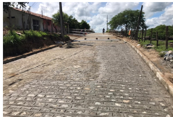
FOTO-6 (ITEM 2.3 - Pavimentação)
