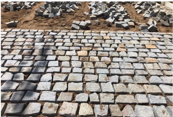
FOTO-3 (ITEM 2.3 - Pavimentação)
