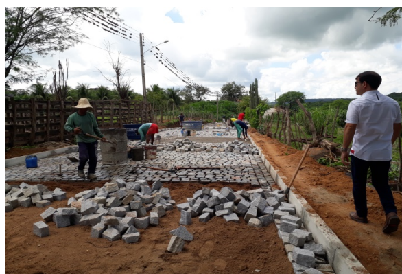
FOTO-4 (ITEM 2.3 - Pavimentação)
