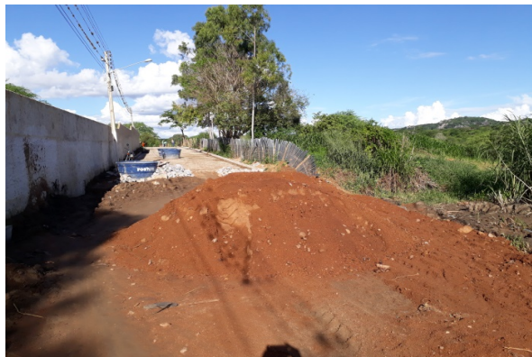
FOTO-1 (ITEM 2.1 - Regularização)
