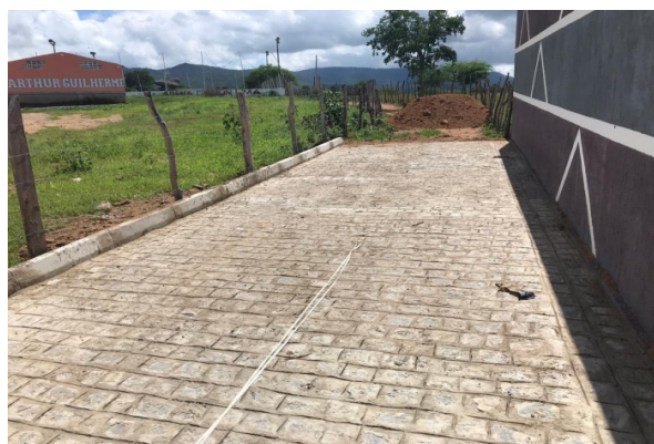
FOTO-3 (ITEM 2.3 - Pavimentação)
