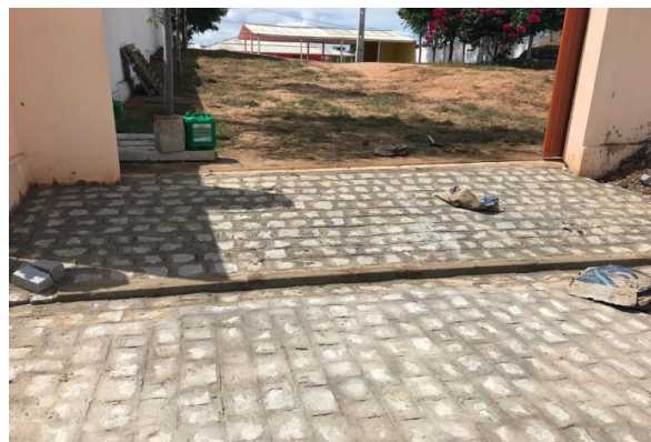
FOTO-7 (ITEM 2.3 - Pavimentação) (Entrada de Residências)
