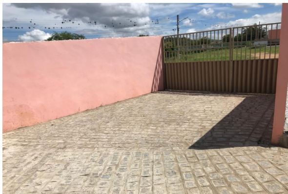
FOTO-7 (ITEM 2.3 - Pavimentação) (Entrada de Residências)
