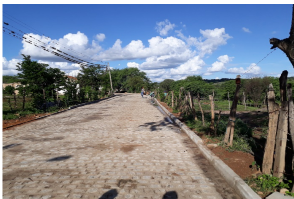
FOTO-3 (ITEM 2.3 - Pavimentação)
