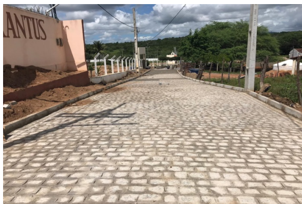
FOTO-5 (ITEM 2.3 - Pavimentação) (Via Secundária)
