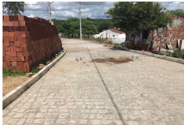
FOTO-4 (ITEM 2.3 - Pavimentação)
