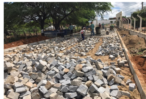
FOTO-6 (ITEM 2.3 - Pavimentação) (Via Secundária)
