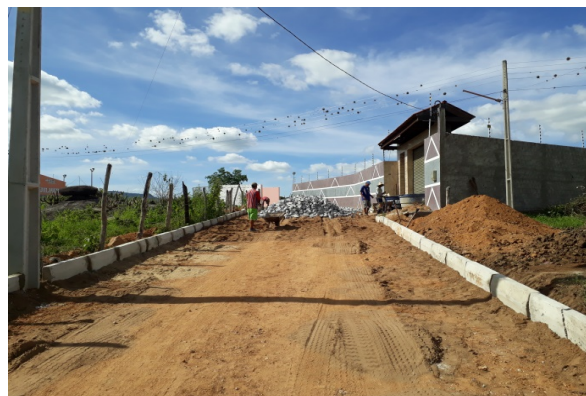
FOTO-2 (ITEM 2.2 - Meio Fio)
