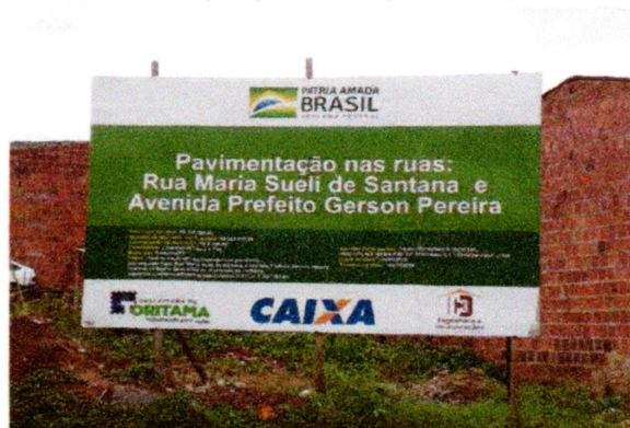
Foto-18 (PLACA DA OBRA)
