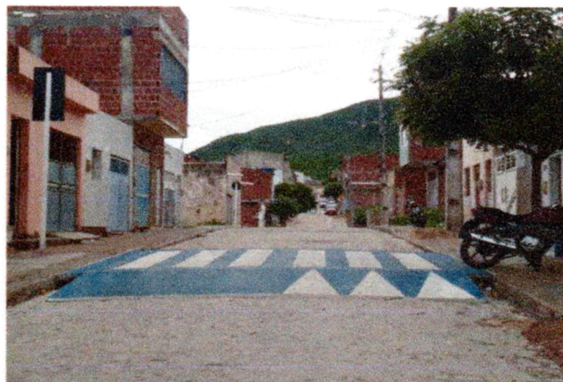
Foto-08 (Rua Maria Sueli de Santana) - FAIXA ELEVADA
