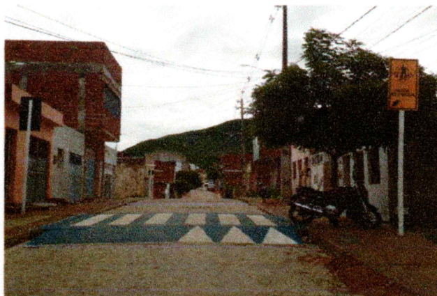
Foto-10 (Rua Maria Sueli de Santana) - SINALIZAÇÃO VERT.
