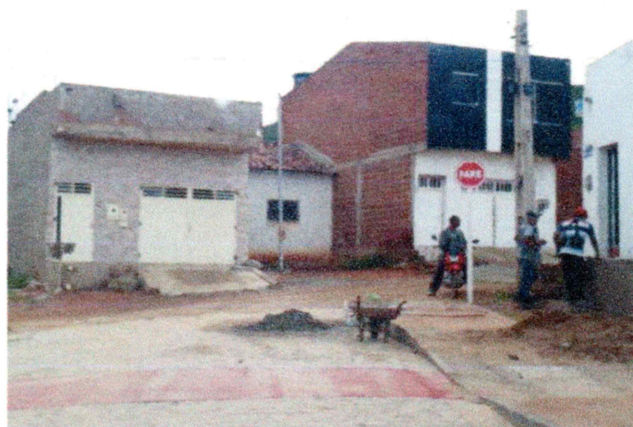
Foto-11 (Rua Maria Sueli de Santana) - SINALIZAÇÃO VERT.
