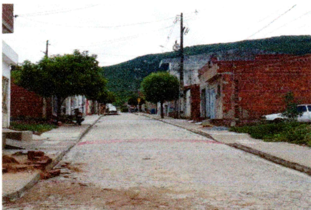
Foto-05 (Rua Maria Sueli de Santana) - concluída
