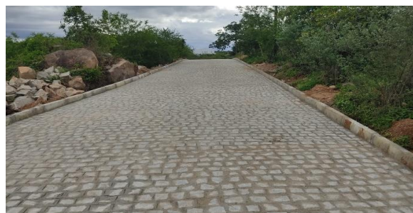
VIA PRINCIPAL (Trecho entre à estaca E60+10,00 à E70+0,00) SENTIDO FAZENDA VELHA
