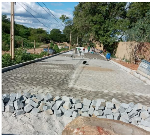
VIA PRINCIPAL (Trecho entre à estaca E70+10,00 à E73+0,00) SENTIDO FAZENDA VELHA
