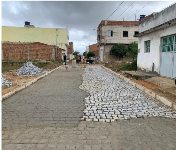
Rua Severino Amaro Menino - Trecho 2 da E6+10,00 à E7+10,00
