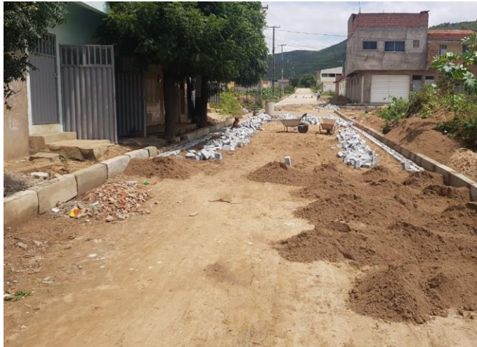
Rua Via Projetada 20 S4Q124Q125 - Trecho 4 da E09+15,00 à E11+17,41
