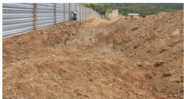
Escavação de valas em material de 1ª categoria p/ fundação dos muros de contenção (Lado esquerdo da obra)
