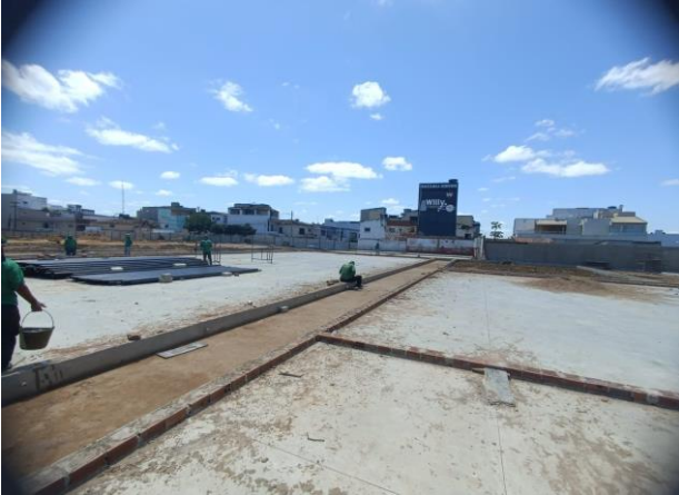
FOTO - 15 Quadra de Futmesa e areia (avenaria, chapisco e emboço)
