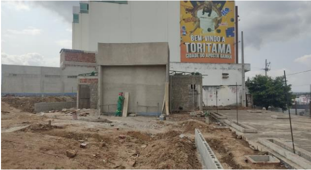
FOTO - 27 Banheiro Piquenique - Resvestimentos (Chapisco e emboço)
