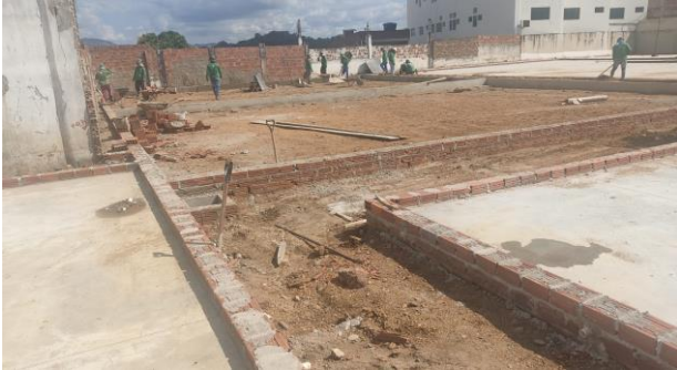
FOTO - 21 Quadra de Beach Tennis (avenaria, chapisco e emboço)
