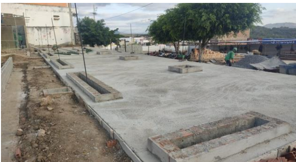
FOTO - 31 Área de Piquenique - Chapisco, emboço e conc. Magro
