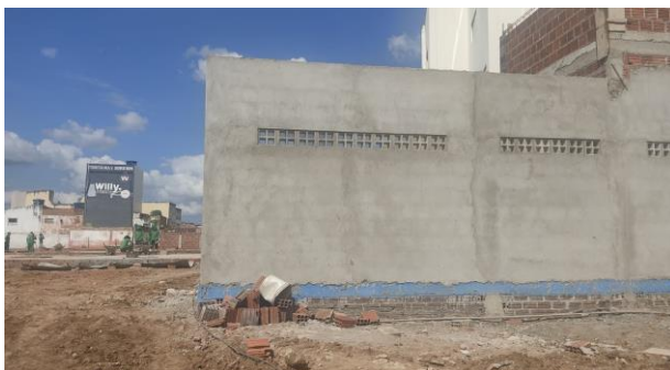
FOTO - 37 Alojamento - Alv., Chapisco, emboço, forma e concreto
