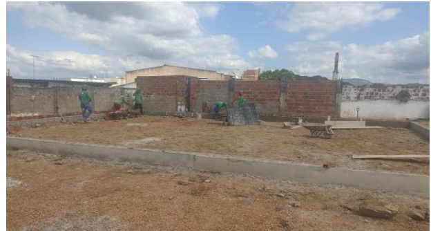
FOTO - 22 Quadra de Beach Tennis (avenaria, chapisco e emboço)
