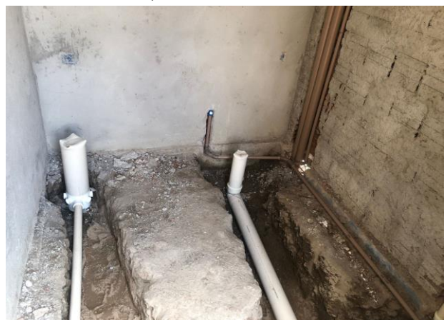
FOTO - 26 Banheiro de Esportes - Inst. Hidráulica e Sanitária
