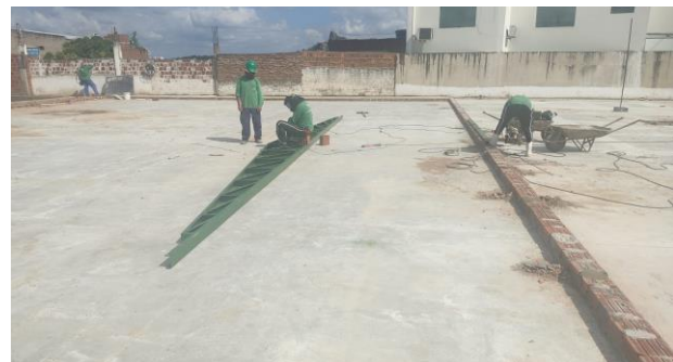
FOTO - 20 Quadra Poliesportiva (avenaria, chapisco e emboço)
