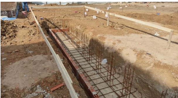
FOTO - 13 Fundação do Gazebo
