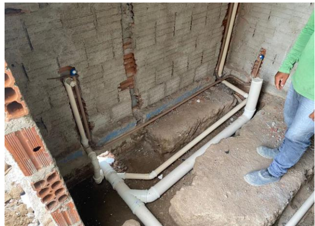
FOTO - 30 Banheiro Piquenique - Inst. Hidráulica e Sanitária
