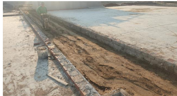
FOTO - 18 Campo de Society (avenaria, chapisco e emboço)
