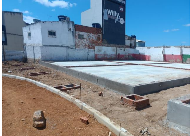
FOTO - 16 Quadra de Futmesa e areia (avenaria, chapisco e emboço)
