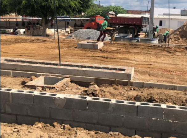
FOTO - 33 Área de Piquenique - Caixas de inspeção e eletrodutos
