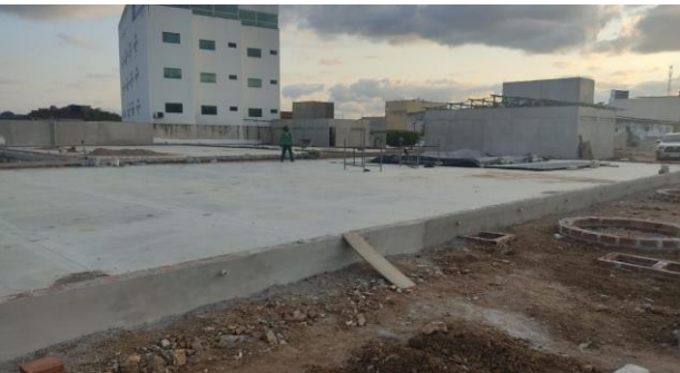
FOTO - 17 Campo de Society (avenaria, chapisco e emboço)
