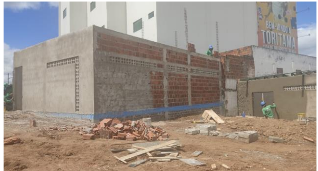
FOTO - 36 Alojamento - Alv., Chapisco, emboço
