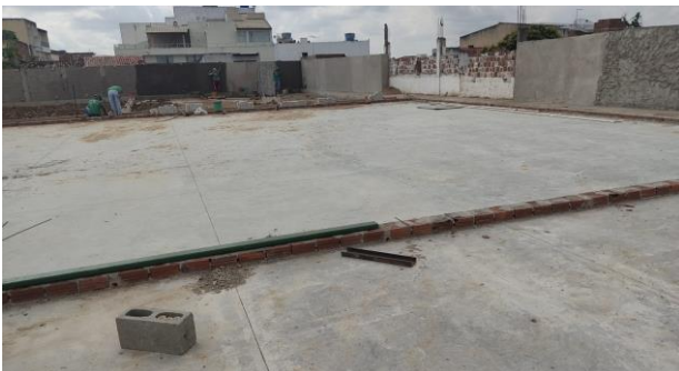
FOTO - 19 Quadra Poliesportiva (avenaria, chapisco e emboço)
