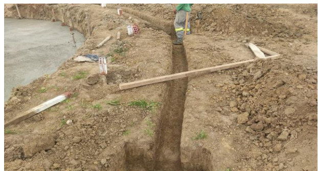
FOTO -6 Escavação das valas p/ colocação dos eletrodutos
