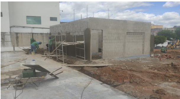
FOTO - 35 Alojamento - Alv., Chapisco, emboço
