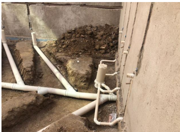
FOTO - 25 Banheiro de Esportes - Inst. Hidráulica e Sanitária
