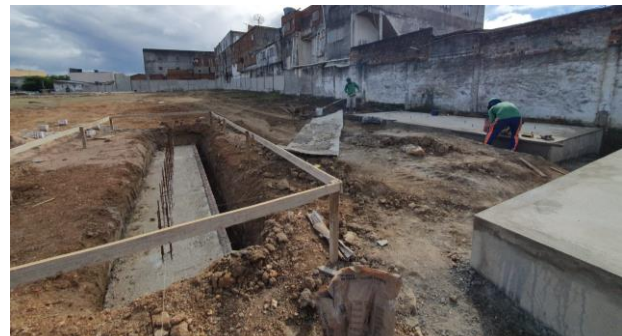
FOTO - 14 Fundação do Gazebo
