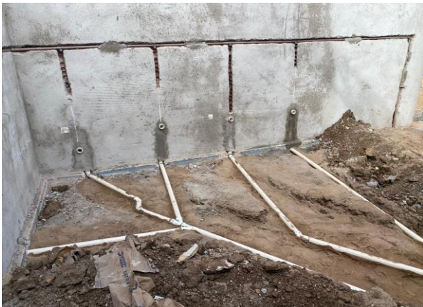
FOTO - 29 Banheiro Piquenique - Inst. Hidráulica e Sanitária
