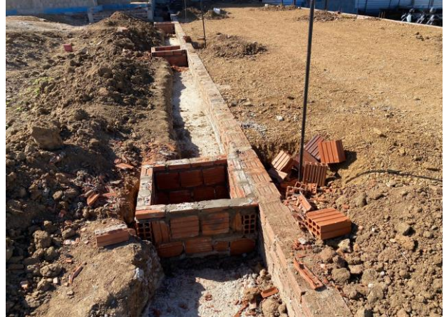
FOTO - 34 Área de Piquenique - Caixas de inspeção e eletrodutos
