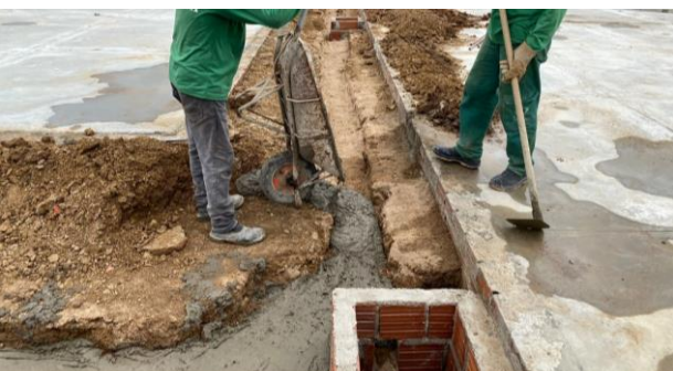
FOTO -7 Envolvimento dos eletrodutos
