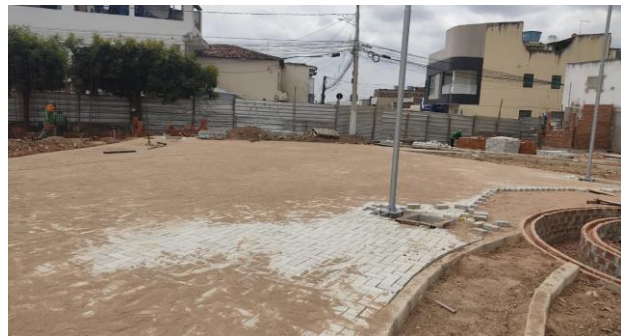
FOTO - 20 Piso em intertravado e postes de 9m (área de eventos e espelhos d' água)
