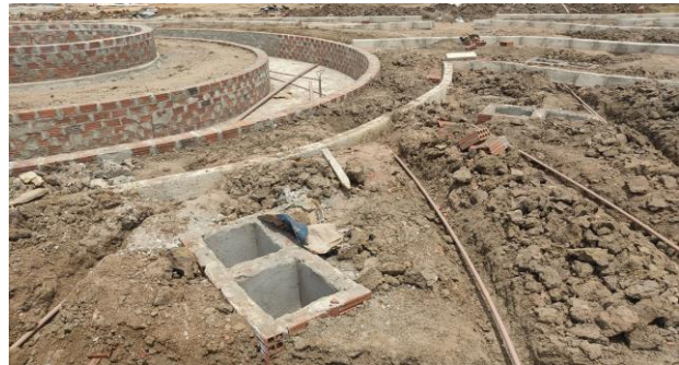
FOTO - 12 Rede de água (edificações e irrigação)
