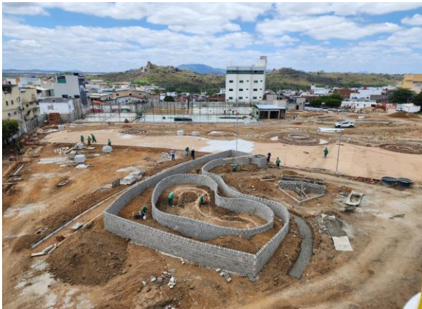
FOTO - 17 Piso em intertravado (área de eventos e espelhos d' água)
