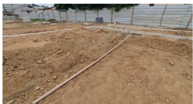
FOTO -8 Rede de água (edificações e irrigação)
