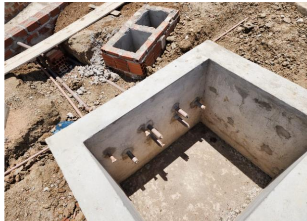
FOTO - 24 Quadra Poliesportiva (avenaria, chapisco e emboço)
