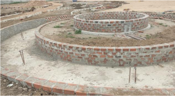
FOTO - 21 Instalações hidráulica (área de eventos e espelhos d' água)
