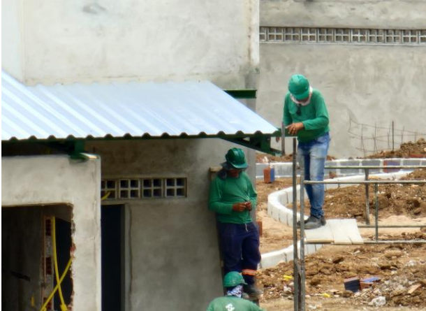
FOTO - 33 Cobertura dos banheiros (Esportes, Piquenique e Alojamento)
