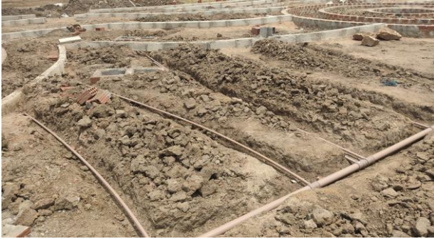
FOTO - 9 Rede de água (edificações e irrigação)
