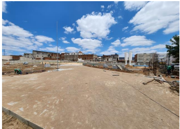
FOTO - 18 Piso em intertravado (área de eventos e espelhos d' água)
