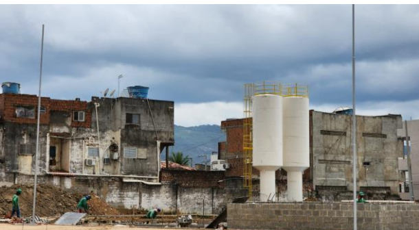
FOTO -7 Poste cônico de 9m
