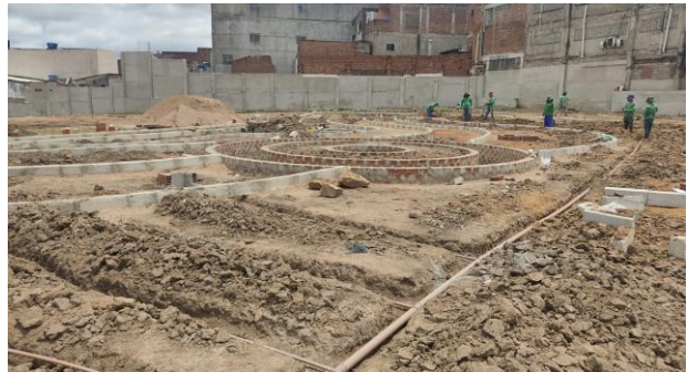
FOTO - 10 Rede de água (edificações e irrigação)
