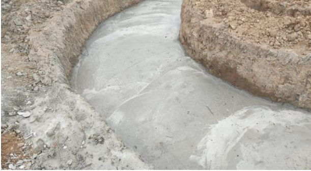
FOTO - 15 Concreto e armação (área de eventos e espelhos d' água)
