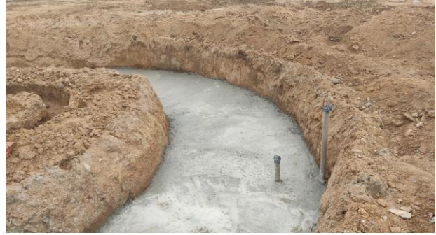
FOTO - 16 Concreto e armação (área de eventos e espelhos d' água)
