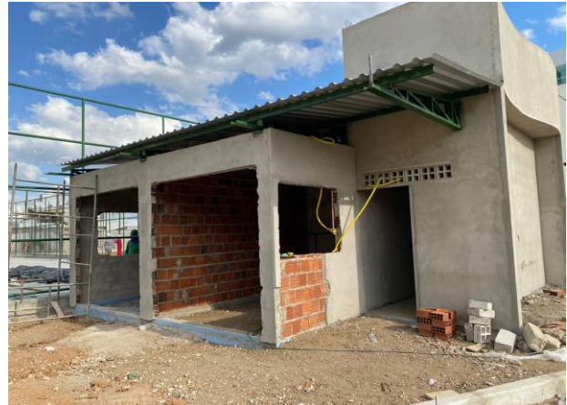
FOTO - 34 Cobertura dos banheiros (Esportes, Piquenique e Alojamento)
