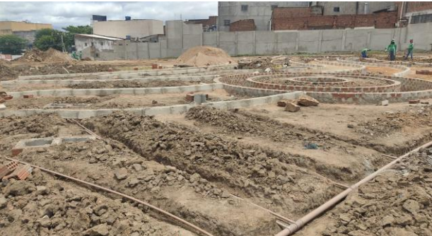
FOTO - 11 Rede de água (edificações e irrigação)
