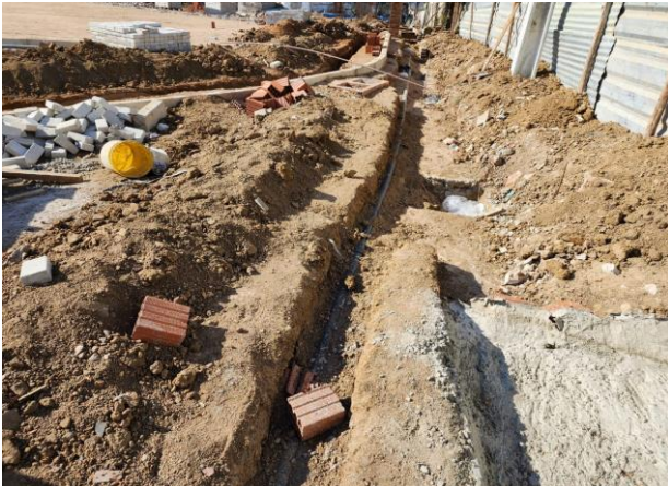
FOTO -3 Escavação das valas p/ colocação dos eletrodutos
