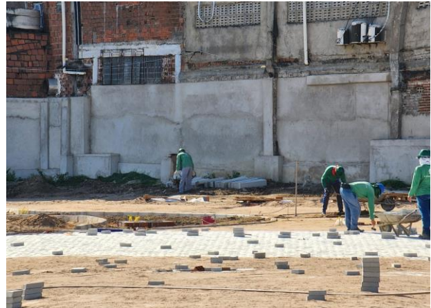
FOTO - 20 Piso em intertravado (área de eventos e espelhos d' água)
