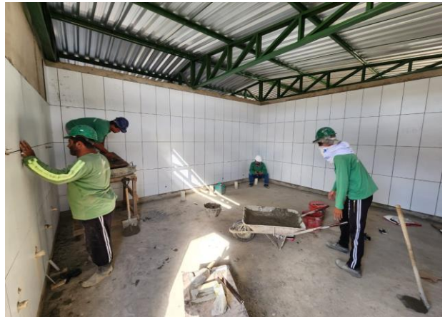
FOTO - 28 Banheiro de Piquenique
