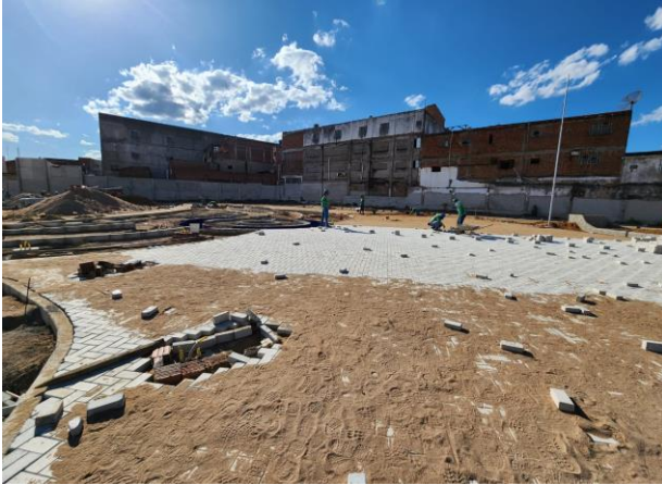
FOTO - 19 Piso em intertravado (área de eventos e espelhos d' água)
