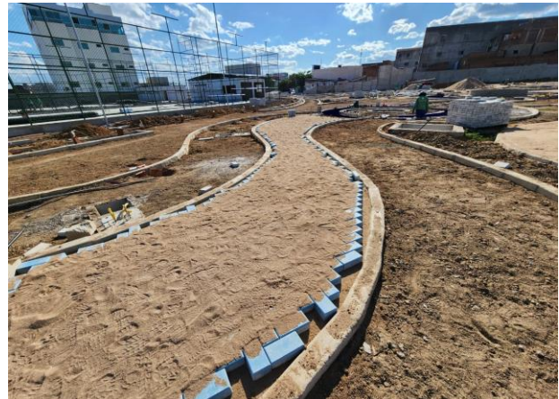
FOTO - 22 Piso em intertravado (área de eventos e espelhos d' água)
