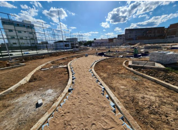
FOTO - 21 Piso em intertravado (área de eventos e espelhos d' água)
