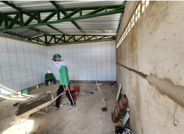
FOTO - 27 Banheiro de Piquenique
