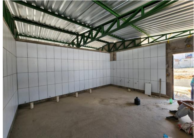
FOTO - 26 Banheiro de Piquenique
