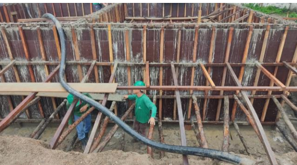
FOTO - 11 Concretagem das paredes do reservatório inferior
