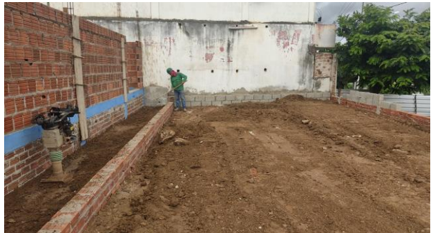
FOTO - 20 Paredes e estrutura do banheiro da área de piquenique
