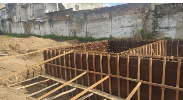
FOTO - 7 Armação e formas das paredes do reservatório inferior
