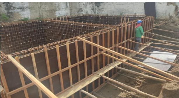
FOTO - 5 Armação e formas das paredes do reservatório inferior
