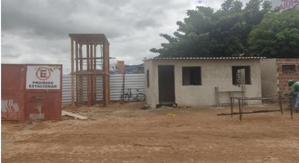
FOTO - 1 Estrutura do reservatório d'água
