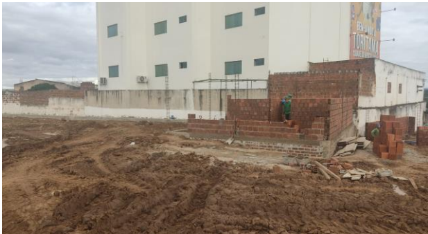
FOTO - 25 Paredes e estrutura dos Banheiros e Vestiário
