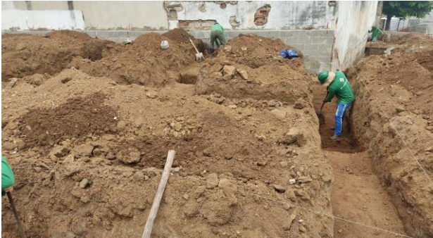
FOTO - 17 Fundações do banheiro da área de piquenique
