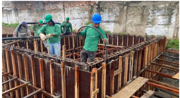
FOTO - 14 Concretagem das paredes do reservatório inferior
