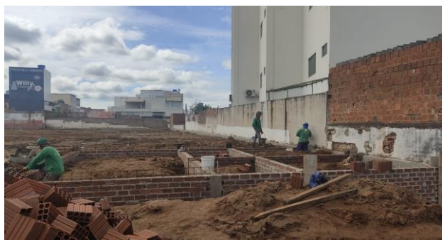
FOTO - 24 Fundações dos Banheiros e Vestiário
