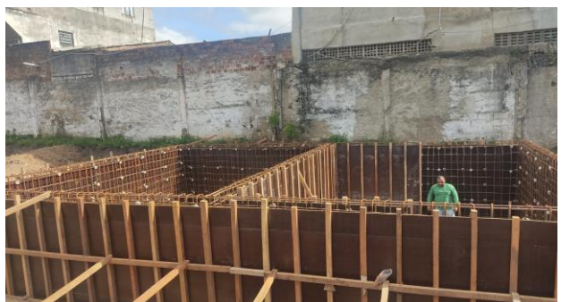
FOTO - 6 Armação e formas das paredes do reservatório inferior
