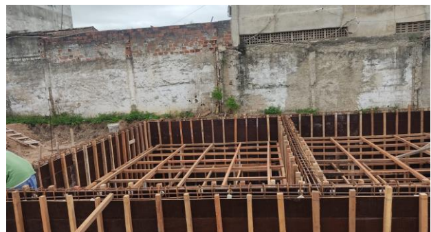
FOTO - 8 Armação e formas das paredes do reservatório inferior
