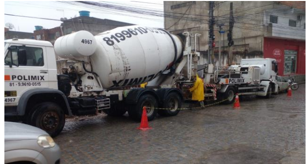
FOTO - 10 Concretagem das paredes do reservatório inferior
