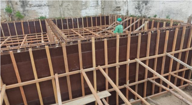
FOTO - 9 Armação e formas das paredes do reservatório inferior
