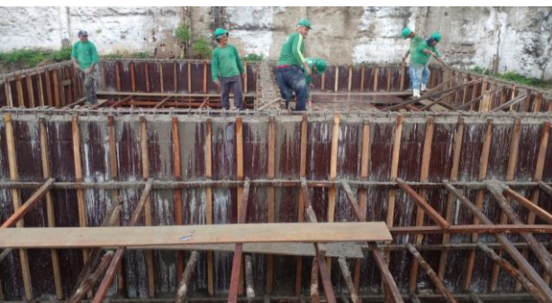
FOTO - 15 Concretagem das paredes do reservatório inferior
