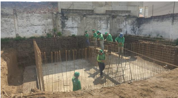
FOTO - 3 Armação da ferragem das paredes do reservatório inferior
