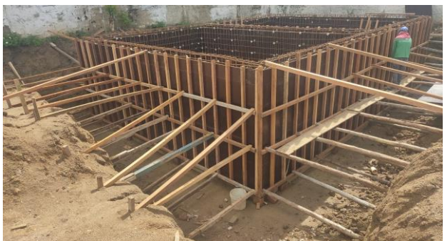
FOTO - 4 Armação e formas das paredes do reservatório inferior
