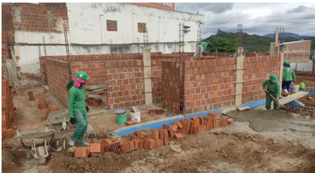
FOTO - 21 Paredes e estrutura do banheiro da área de piquenique
