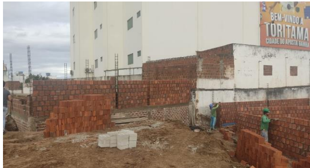
FOTO - 26 Paredes e estrutura dos Banheiros e Vestiário
