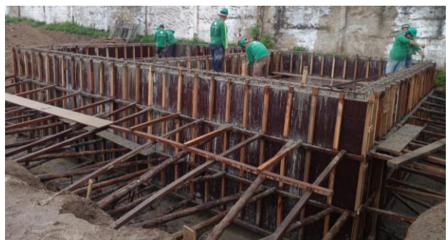
FOTO - 16 Concretagem das paredes do reservatório inferior
