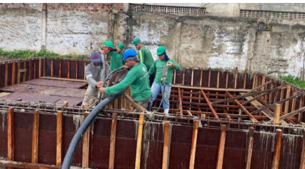
FOTO - 13 Concretagem das paredes do reservatório inferior
