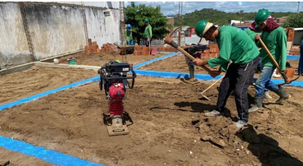
FOTO - 19 Fundações do banheiro da área de piquenique
