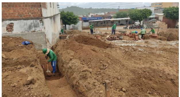
FOTO - 22 Fundações dos Banheiros e Vestiário
