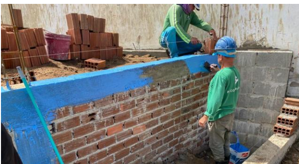
FOTO - 23 Fundações dos Banheiros e Vestiário
