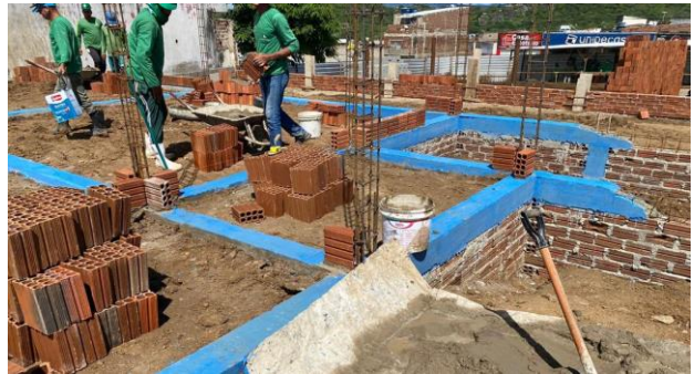
FOTO - 18 Fundações do banheiro da área de piquenique
