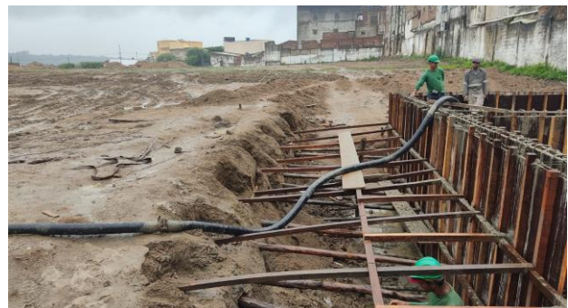
FOTO - 12 Concretagem das paredes do reservatório inferior
