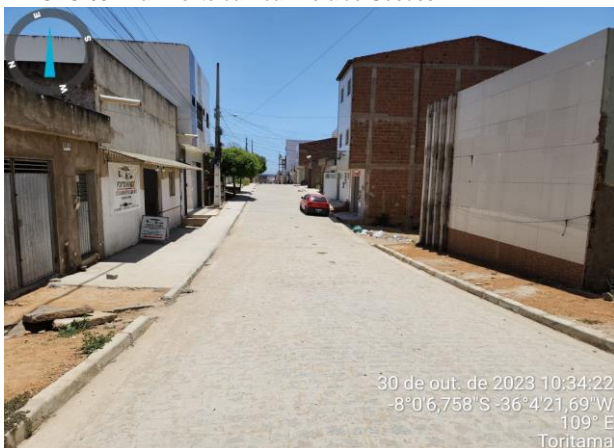
FOTO-11 - Pavimento da Rua Everaldo Guedes
