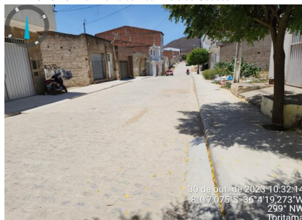
FOTO-12 - Pavimento da Rua Everaldo Guedes
