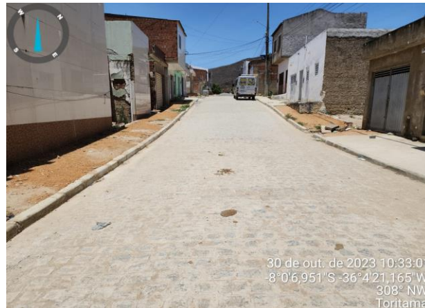
FOTO-04 - Pavimento da Rua Everaldo Guedes
