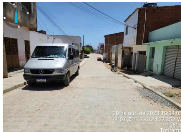
FOTO-08 - Pavimento da Rua Everaldo Guedes
