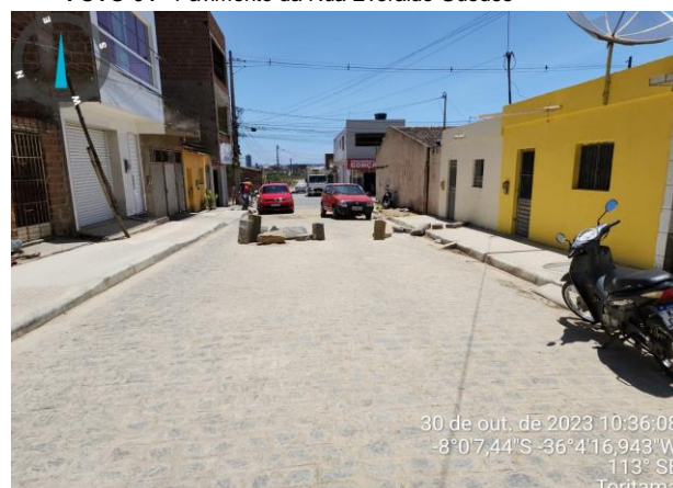
FOTO-06 - Pavimento da Rua Everaldo Guedes
