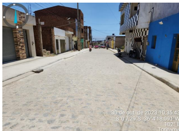
FOTO-02 - Pavimento da Rua Everaldo Guedes
