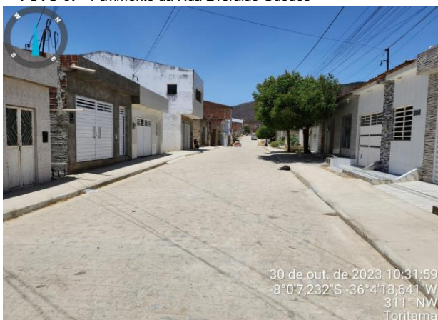
FOTO-09 - Pavimento da Rua Everaldo Guedes
