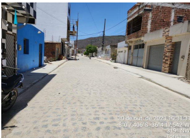
FOTO-07 - Pavimento da Rua Everaldo Guedes
