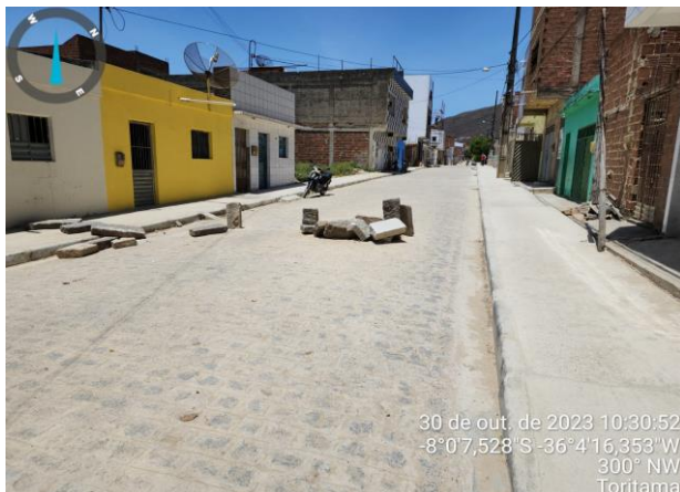
FOTO-03 - Pavimento da Rua Everaldo Guedes
