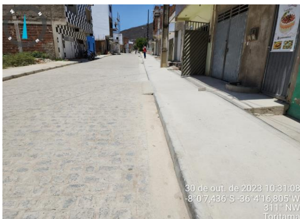
FOTO-01 - Pavimento da Rua Everaldo Guedes
