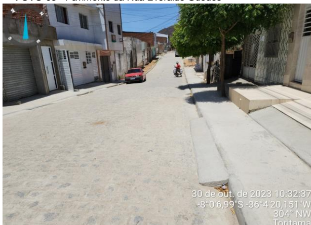
FOTO-05 - Pavimento da Rua Everaldo Guedes
