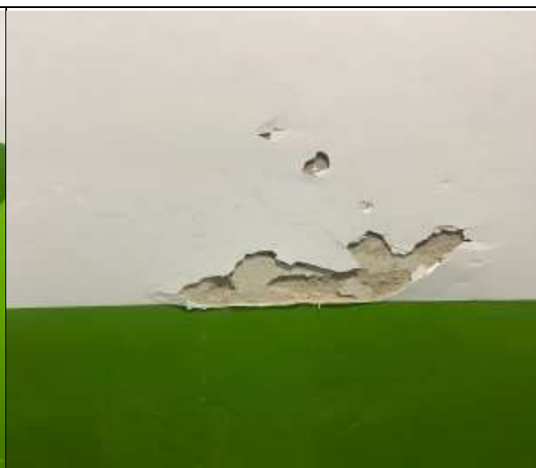
Figura 2 PAREDE COM INFILTRAÇÃO.
