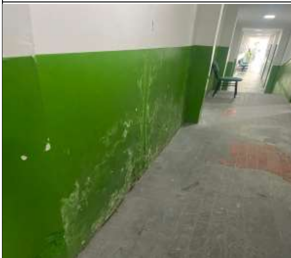
Figura 1 PAREDE COM INFILTRAÇÃO.
