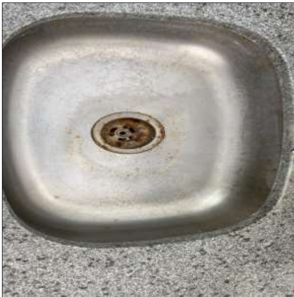
Figura 1 NECESSÁRIO SUBSTITUIÇÃO DA VÁLVULA DA CUBA.
