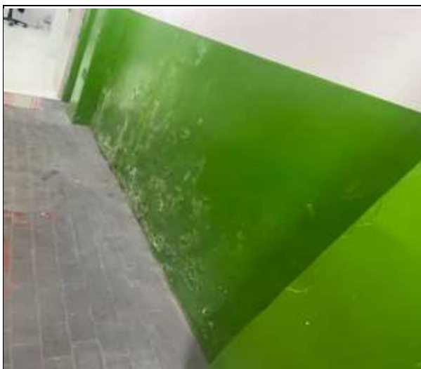
Figura 1 PAREDE COM INFILTRAÇÃO.
