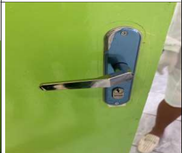
Figura 8 REPARO NA FECHADURA.
