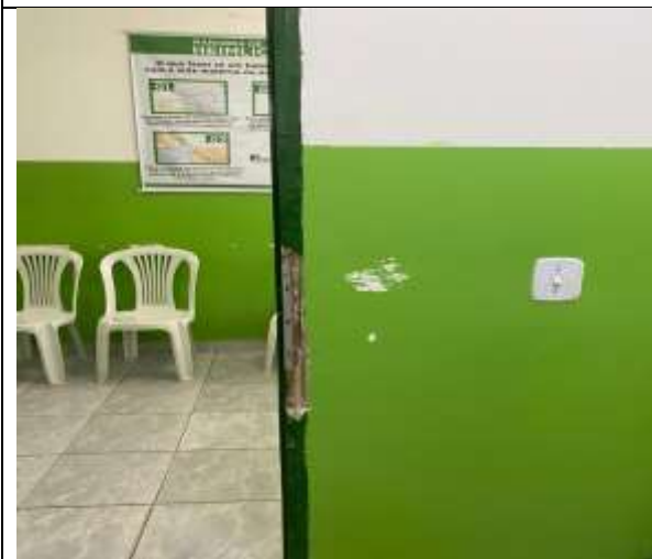
Figura 7 REPARO NA PORTA.
