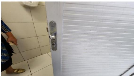
**Figura 13:** Porta com fechadura danificada
