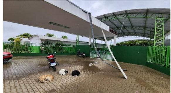
**Figura 02:** Forro de pvc danificado
