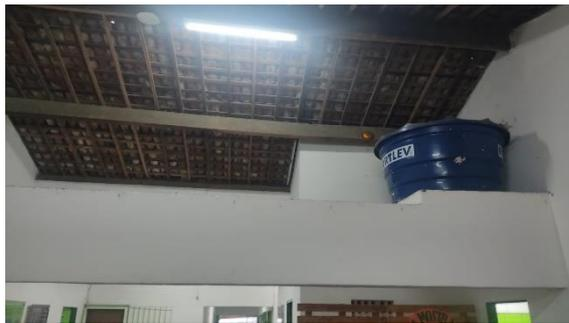
**Figura 09:** Cobertura em telha canal
