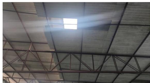
**Figura 06:** Telhado da quadra danificado
