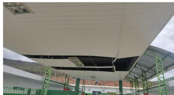
**Figura 08:** Forro de pvc danificado na entrada principal
