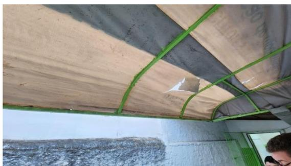
**Figura 15:** Forro de cobertura rasgado
