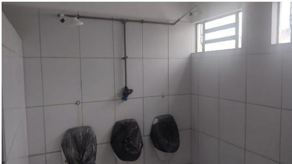
**Figura 11:** Encanamento dos mictórios danificados
