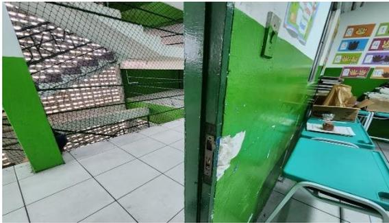
**Figura 09:** Porta com fechadura danificada
