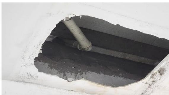
**Figura 07:** Forro da sala danificado
