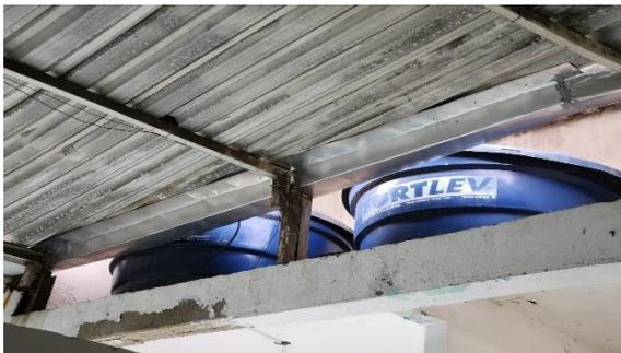
**Figura 13:** Patologia estrutural na viga de apoio da caixa d'água
