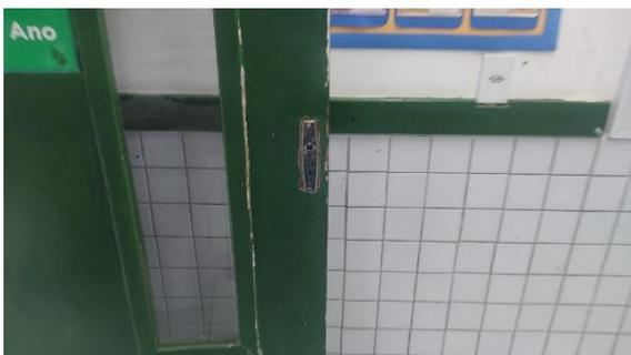
**Figura 15:** Porta com fechadura danificada
