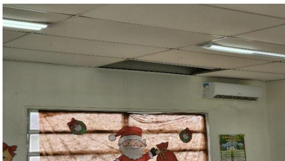
**Figura 13:** Forro danificado localizado na sala de aula
