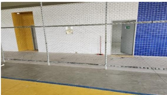
**Figura 07:** Alambrado danificado na área da quadra
