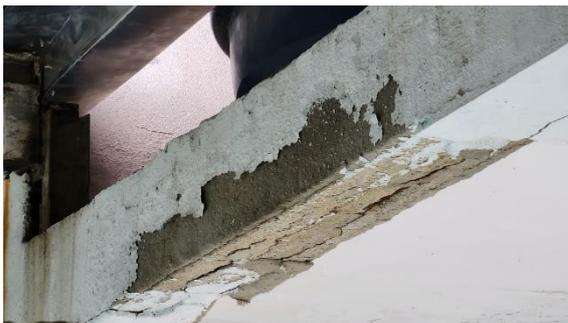
**Figura 15:** Patologia estrutural na viga de apoio da caixa d'água
