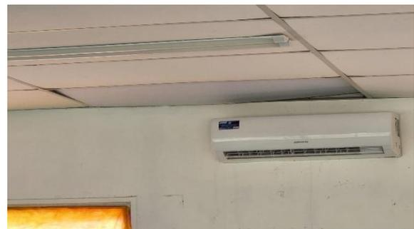
**Figura 12:** Forro danificado localizado na sala de aula
