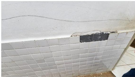
**Figura 09:** Deslocamento da cerâmica na parede
