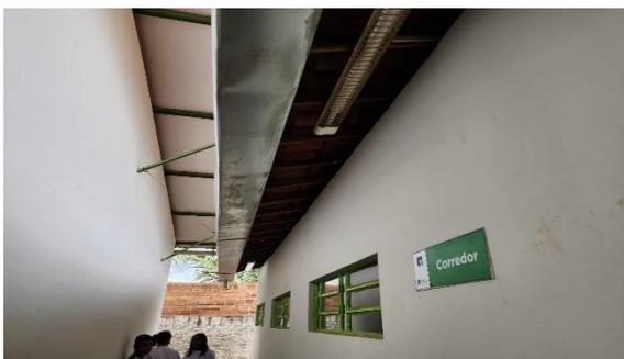
**Figura 07:** Calha trocada entre as salas
