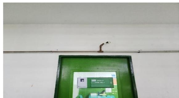
**Figura 08:** encanação adaptável do fluido do ar-condicionado vazando
