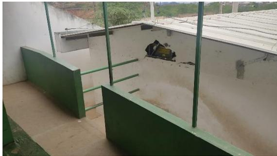
**Figura 11:** Placa cimentícia danificada
