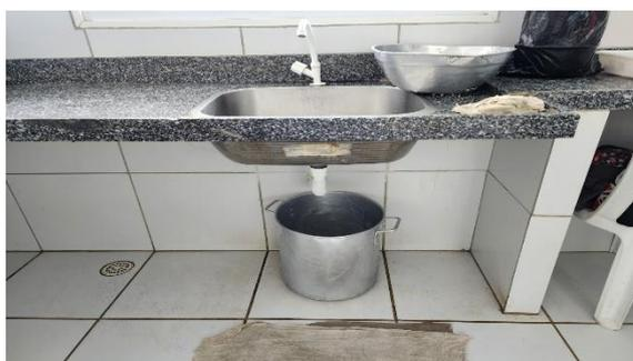
**Figura 15:** Sistema hidráulico danificado
