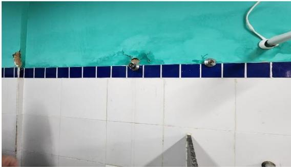
**Figura 15:** Descargas quebradas
