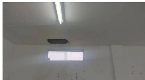
**Figura 08:** Forro da sala danificado
